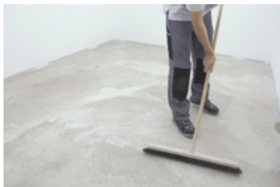
2. Säubern und Grundieren des Untergrundes
