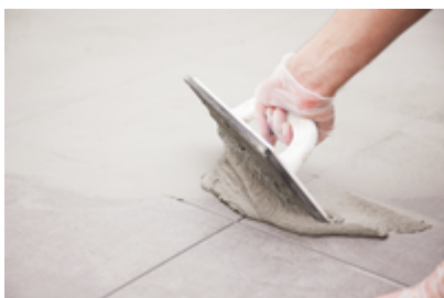
16. Die Belagsverfugung erfolgt nach Begehbarkeit der Belagsfläche.
