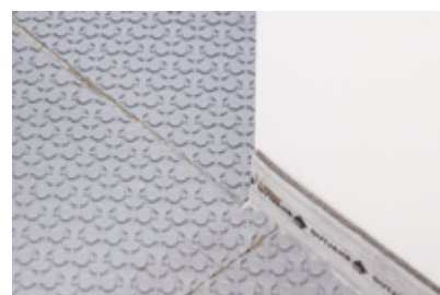
9. ... dieser Fugenbereich muss mit einem handelsüblichen Krepp-Klebeband in ausreichender Breite abgedeckt werden. Feldbegrenzungsfugen zur Unterteilung großflächiger Belagsflächen werden im Zuge der Belagsverlegung oberhalb der ARDEX FLEXBONE® ausgebildet.
