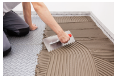
12. der ARDEX Fliesenkleber direkt mit geeigneter Zahnung aufgezogen.
