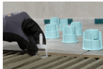
15. Zur Vermeidung von Überzähnen an der Belagsoberseite kann das ARDEX Nivelliersystem eingesetzt werden.
