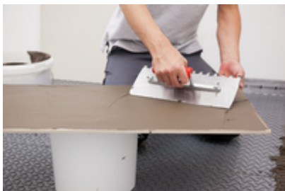
13. Die Klebemörtelstärke zwischen Oberkante ARDEX FLEXBONE® und Fliesenunterseite darf 5 mm nicht übersteigen. Mit schwundkompensierten Mittelbettklebemörteln sind Kleberbettstärken bis 10 mm möglich.
