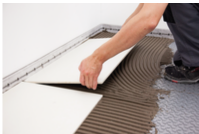
14. Der Belag wird voll satt in das Kleberbett gebettet. Insbesondere bei großformatigen Fliesen ist eine Verlegung im kombinierten Verfahren zweckmäßig. Es ist mit einer längeren Abbindezeit des Fliesenklebers zu rechnen.
