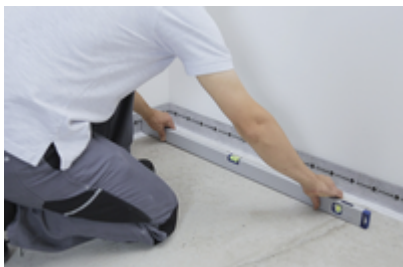
1. Prüfung des Untergrundes auf Eignung und Ebenflächigkeit.
