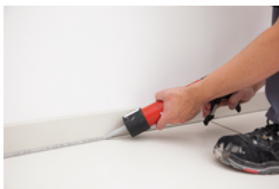
17. Ausbildung von Anschluss- und Bewegungsfugen mit geeigneten ARDEX Silikonen.
