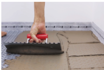
11. oder der Fliesenbelag wird „Frisch in Frisch“ mit Klebemörtel verlegt. Hierzu wird die ARDEX FLEXBONE® Zug um Zug ausgespachtelt und ...
